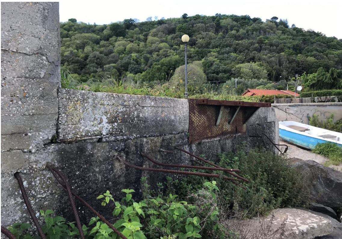
Figura 4. Dettaglio testata banchina attuale
