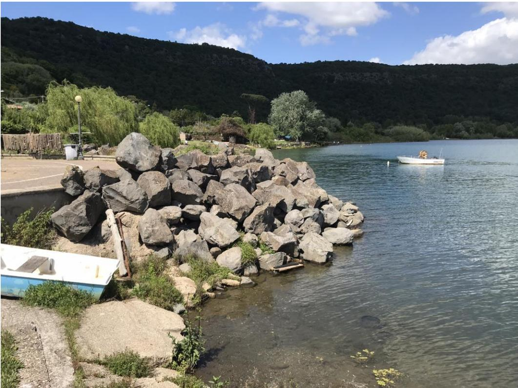
Figura 6. Vista della scogliera di protezione della banchina
