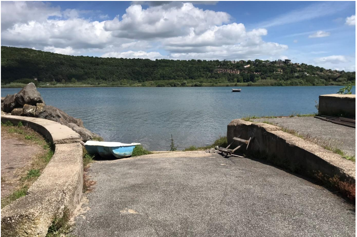
Figura 5. Vista radice pontile - stato ante operam
