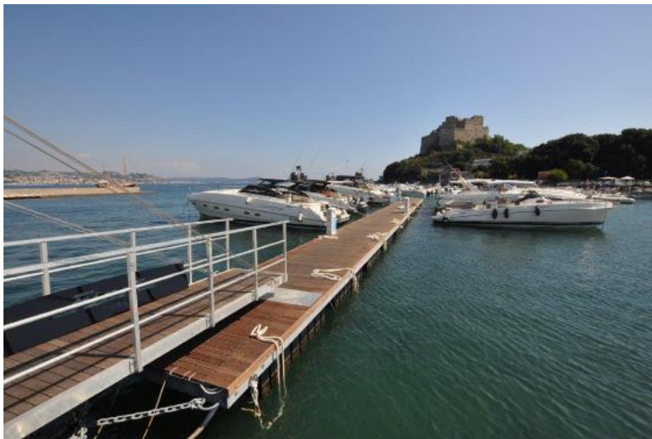
Figura 4. Esempio di realizzazione approdo con pontile galleggiante
