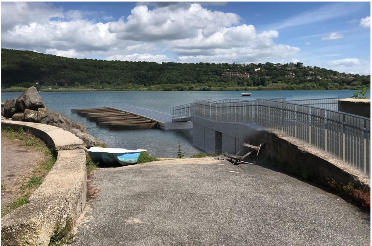
Figura 6. Vista radice pontile - stato post operam
