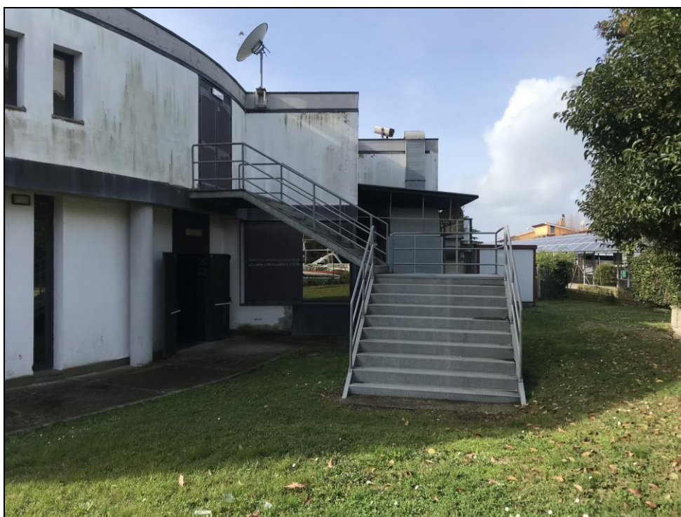
Figura 11. Prospetto laterale dell'edificio per il quale è prevista la demolizione.
