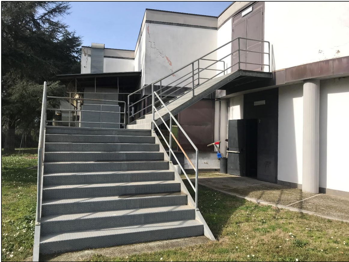
d) Prospetto laterale dell'edificio di cui è prevista la demolizione.
