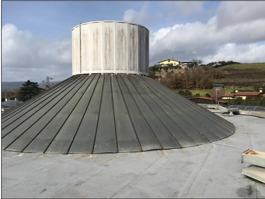
b) Copertura dell'edificio di cui è prevista la demolizione.
