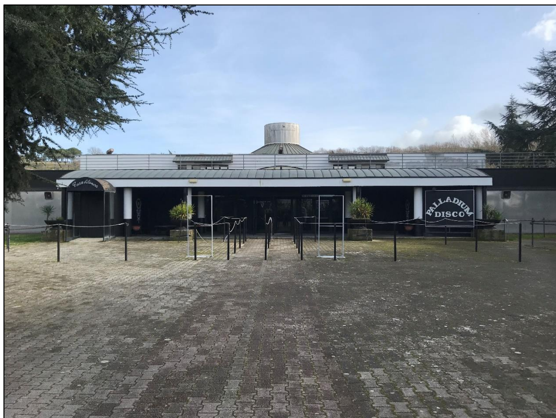
a) Prospetto principale dell'edificio di cui è prevista la demolizione.
