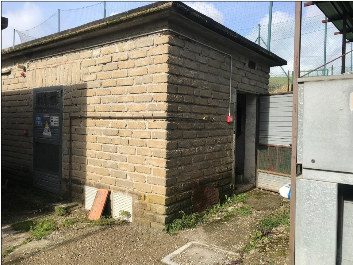
c) Locali tecnici di cui è prevista la demolizione.
