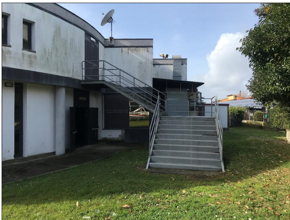
Prospetto laterale dell'edificio per il quale è prevista la demolizione.
