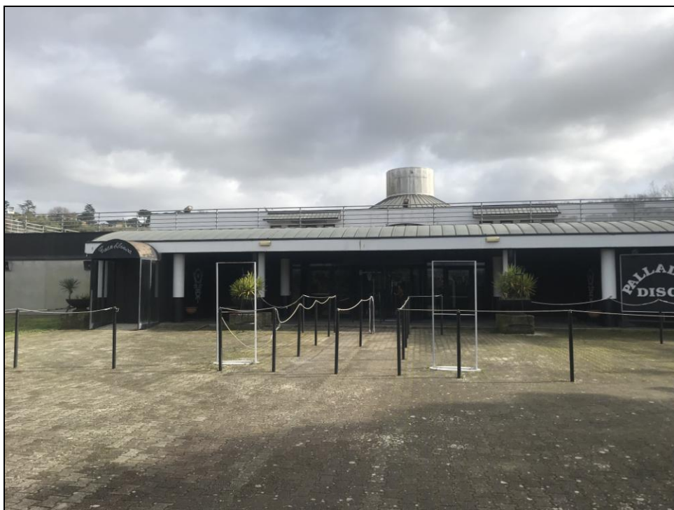
Figura 10. Prospetto dell'edificio per il quale è prevista la demolizione.
