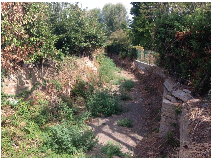
Alveo del Fosso della Morichella a monte del ponte stradale- Sezione n.5
