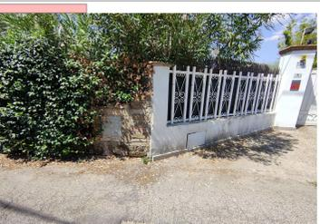
Muro Tufo intonacato fino h 1.7 m + muro tufo con copertina in cls h 0.5m con Ringhiera fino h 1.2 m
