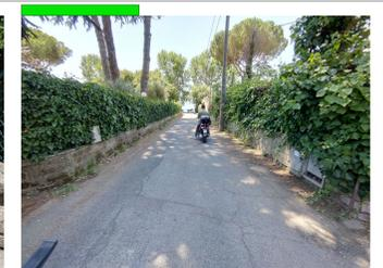
Muro Tufo fino h 0.6 m + Ringhiera fino a 1 m
