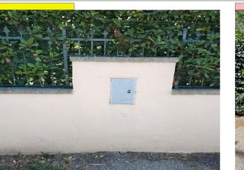
Muro Tufo intonacato con copertina in cls fino h 1.1 m + Ringhiera fino h 0.9 m
