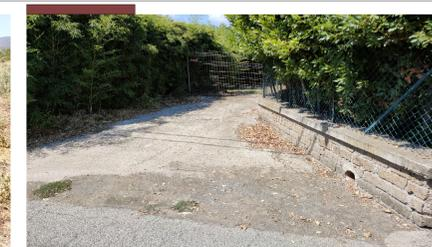
Muro Tufo con copertina in cls fino h 0.6 m + Rete fino a 1.2 m
