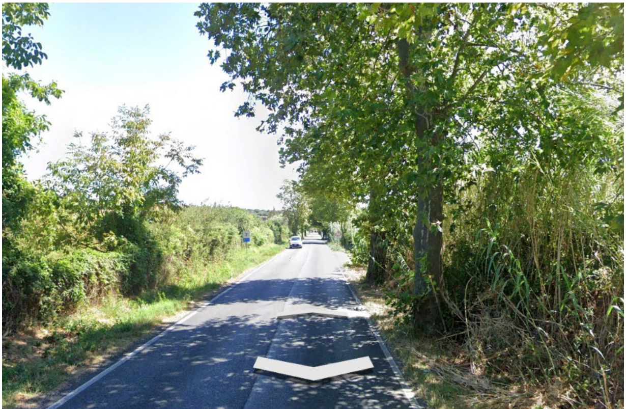
VISTA 2: Ante/Post Operam – La nuova SRB non risulta visibile
